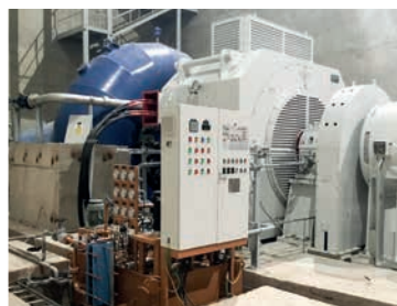
Sap Viet, Vietnam 23,5 MW; zwei große horizontale Francis-Einheiten in Südostasien
