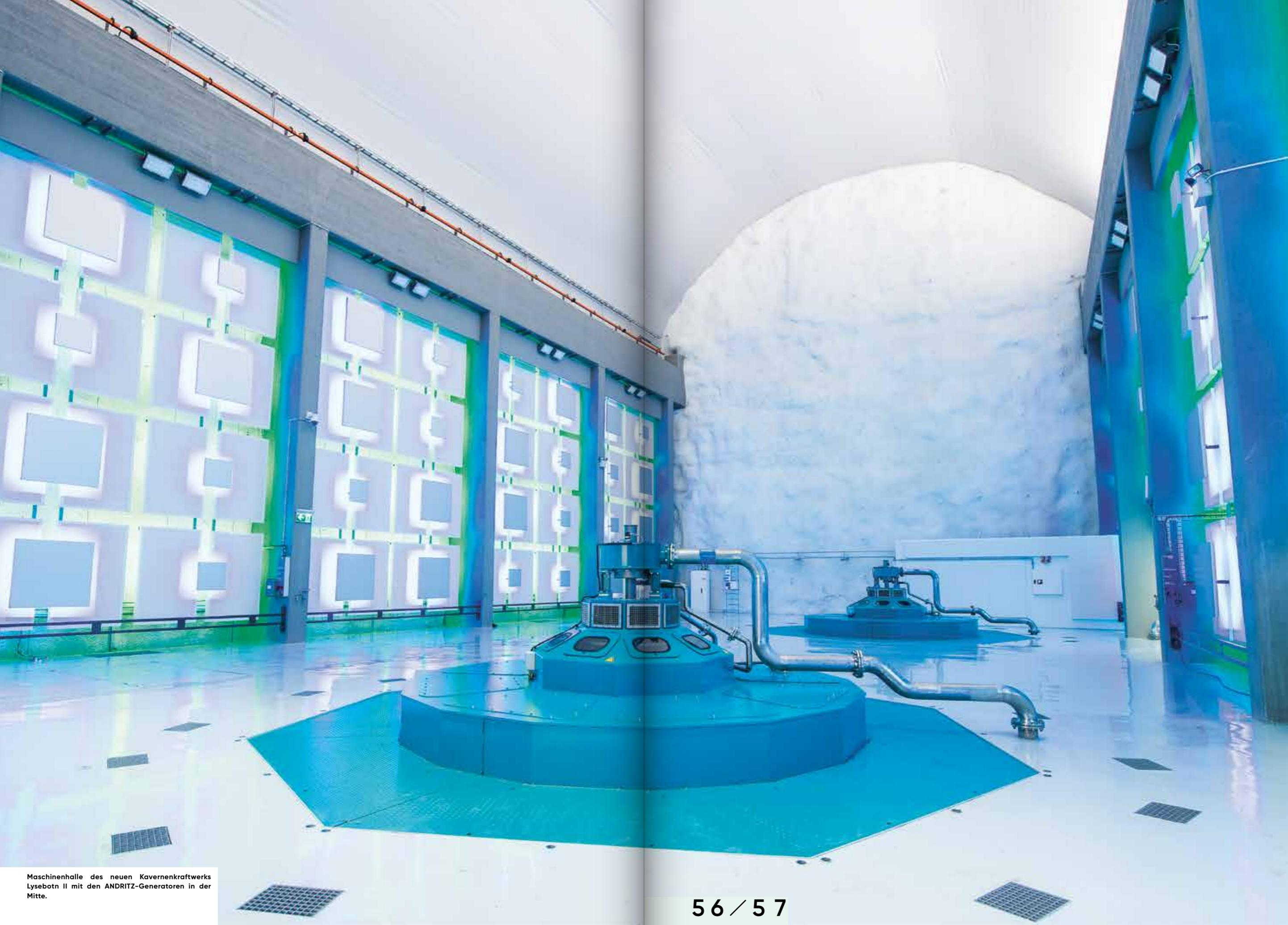
Maschinenhalle des neuen Kavernenkraftwerks Lysebotn II mit den ANDRITZ-Generatoren in der Mitte.
