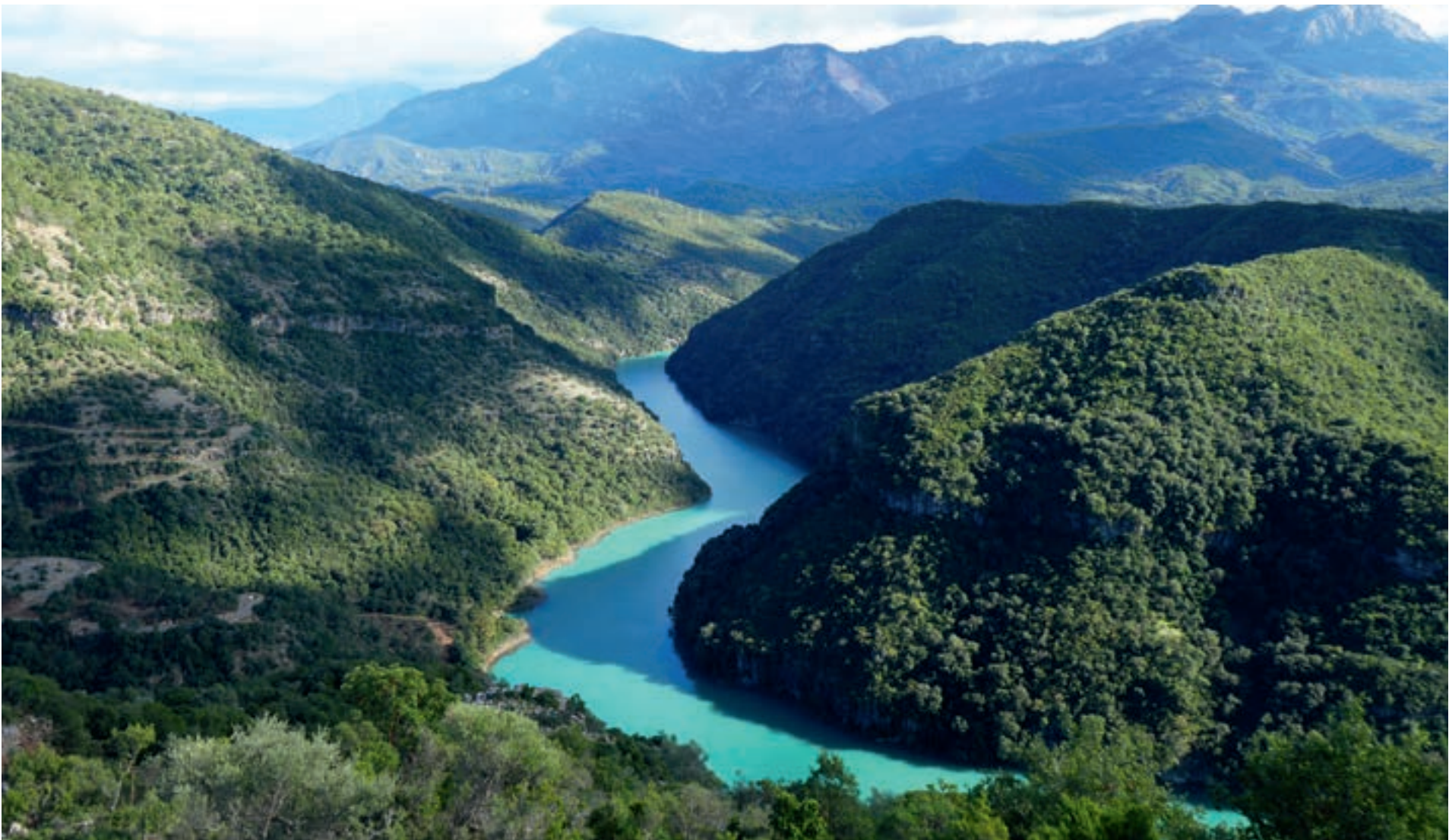
TERNA ENERGY S.A.: Mit einer Kapazität von 680 MW handelt es sich um die größte netzgekoppelte Energiespeicherinvestition des Landes und einen Meilenstein für die Energiewende in Griechenland. ANDRITZ liefert die elektromechanische Ausrüstung für dieses Projekt.
