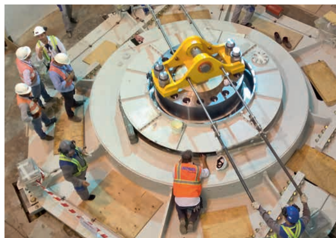
Lowering rotor unit #1 HPPLaúca
