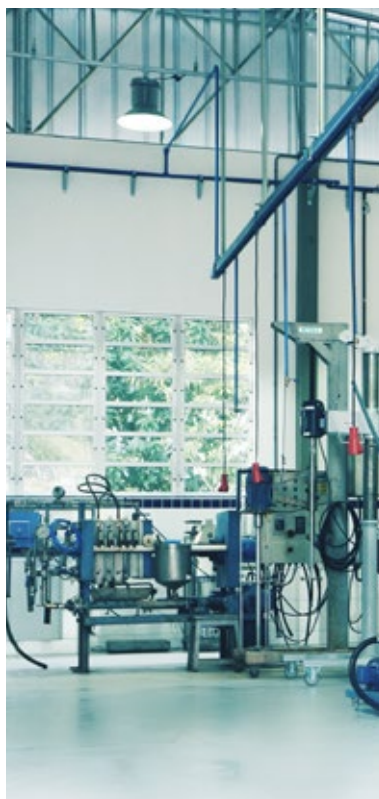
Una de las instalaciones globales de pruebas de ANDRITZ en Pomerode, Brasil
