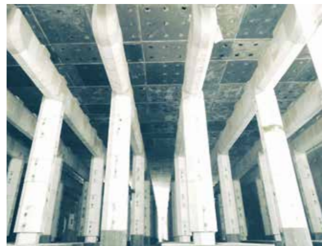
Vorgefertigte Dämmschalen, montiert an einem Hubbalkenofen
