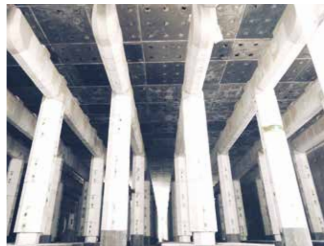
Coques isolantes préfabriquées installées sur un four à longerons mobiles
