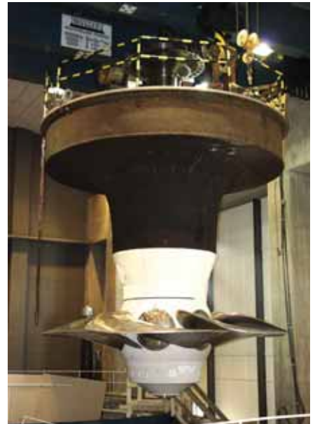
Petäjäsoski 2, Kaplan turbine runner installation
