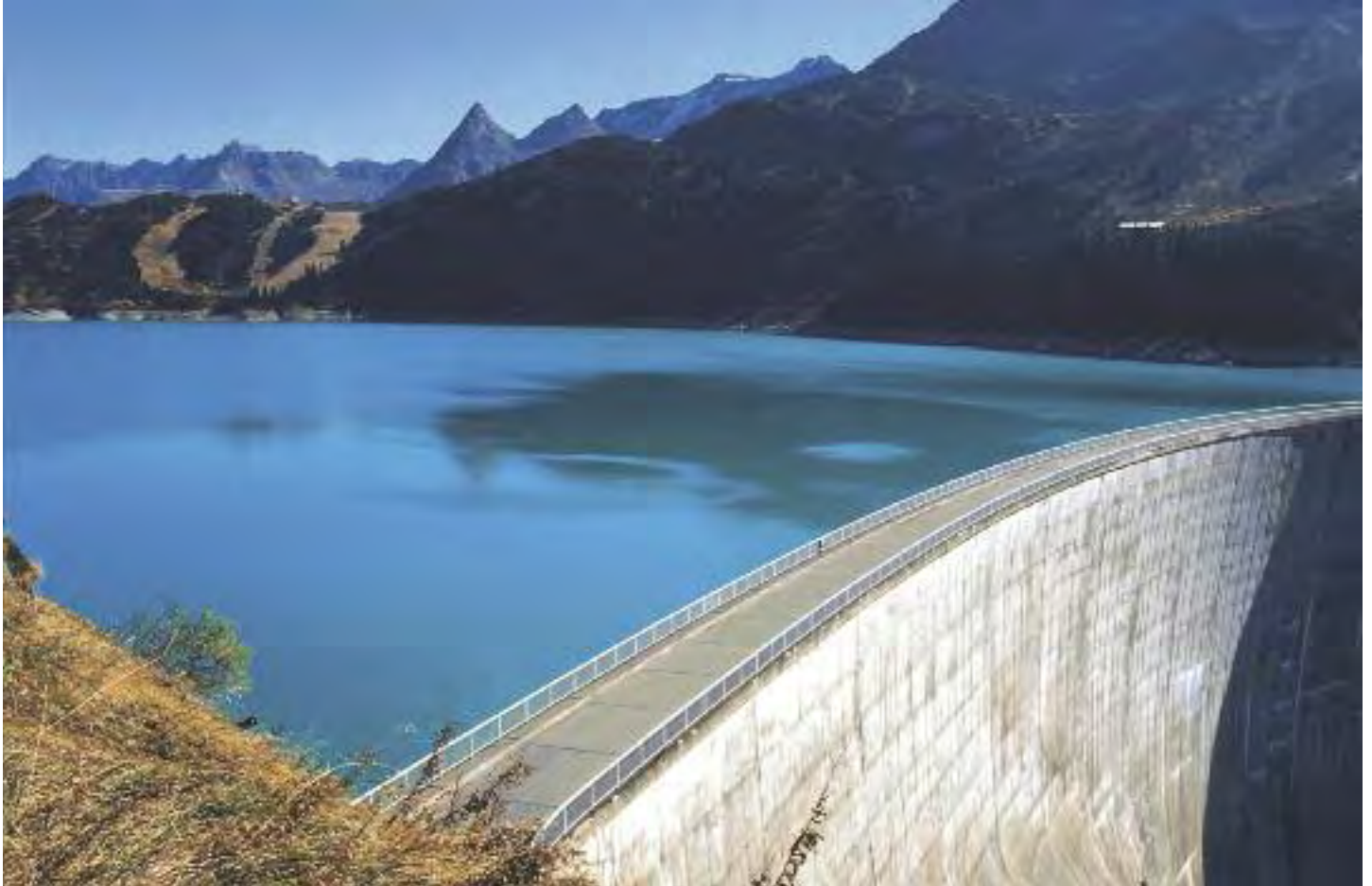
3 x 150 MW, Kopswerke II, Austria
