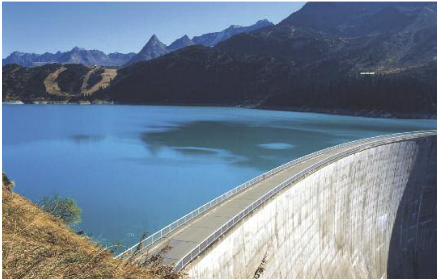
3 x 150МВт, ГЭС Копс II, Австрия
