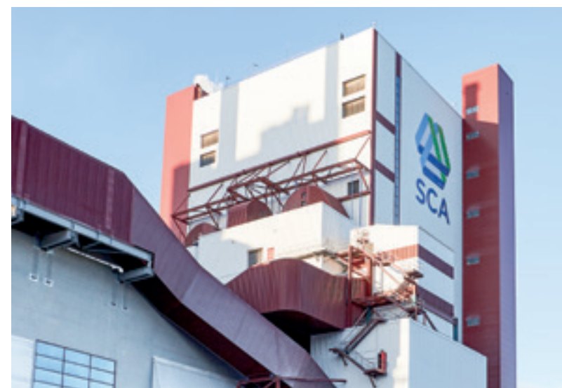
Ширина содорегенерационного котла увеличилась на 3,8 м, а производительность — с 3300 до 5000 т/сутки
