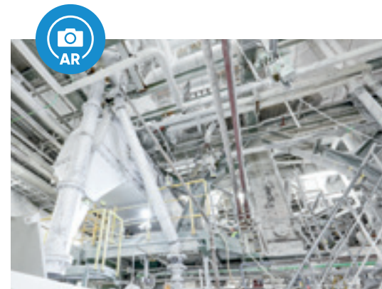
Новая сортировка песка для повторного использования материала кипящего слоя.
