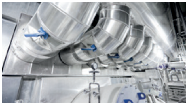
Новый уровень вторичного воздуха усовершенствованной системы стадийного ввода воздуха для снижения уровня выбросов NOx.
