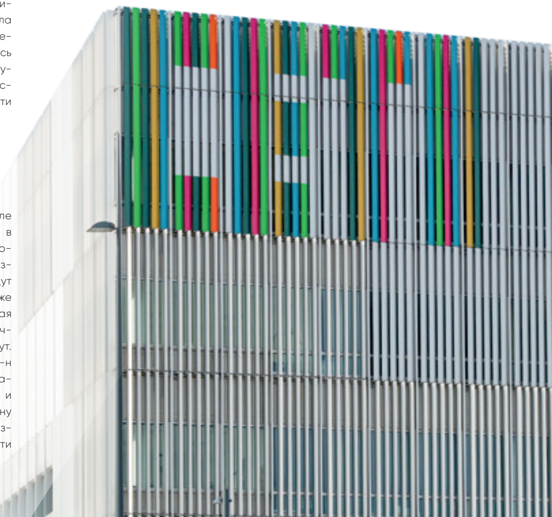
Здание CETI в Туркуэне
