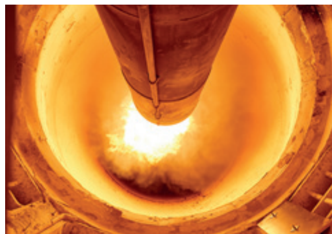
Вид изнутри известерегенерационной печи с древесной мукой в качестве топлива
