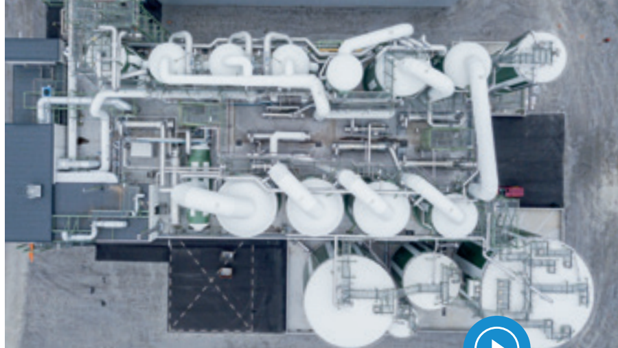
Новая выпарная установка с семью корпусами выпаривания заменит существующие выпарные линии, что значительно повысит энергоэффективность комбината в Мёрруме
