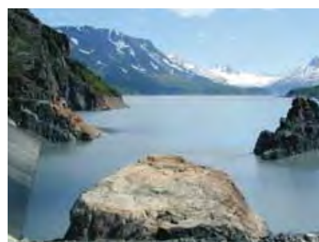
1x 57MW, Bradley Lake, USA
