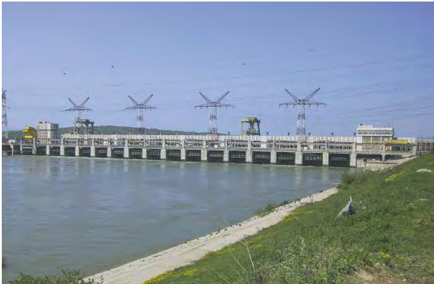
8 x 32 MW, Portile de Fier, Romania
