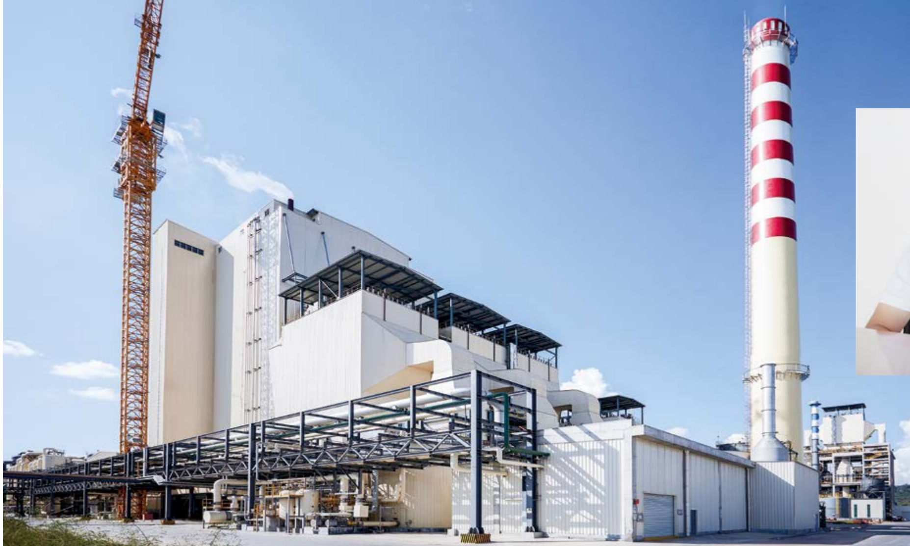
Компания ANDRITZ поставила на комбинат самый большой в Лаосе содорегенерационный котёл HERB с производительностью 2 200 т с.в./день для обеспечения безопасной и надёжной работы.
