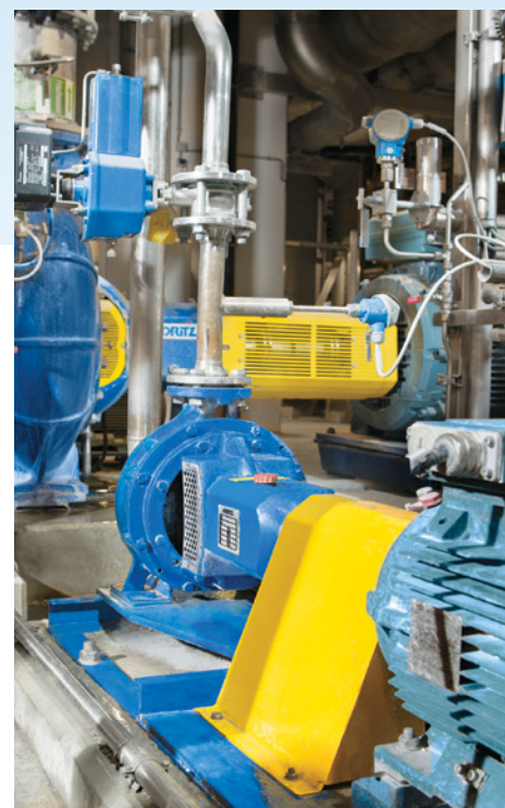
Instalacja z pompami Andritz Seria ISO
