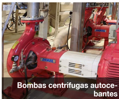
Bombas de centrifugación monoetapa Impulsor semiabierto y abierto
