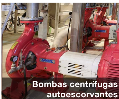
Bombas centrífugas de estágio único Rotor semiaberto ou aberto
