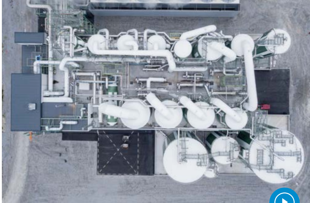
新的7效高固含量的蒸发车间取代现有的蒸发车间,显著提高了Mörrum工厂的能源效率
