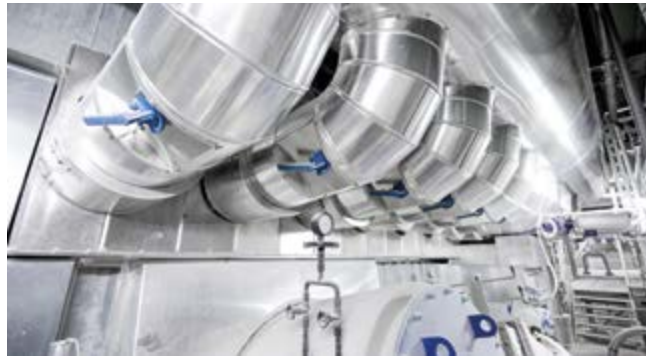
新的二次空气层,用于先进的空气分级以减少氮氧化物的排放。
