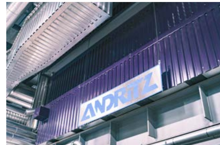
Helsingør Kraftvarmeværk определила цвета для различного оборудования для визуальной идентификации различных элементов котла.
