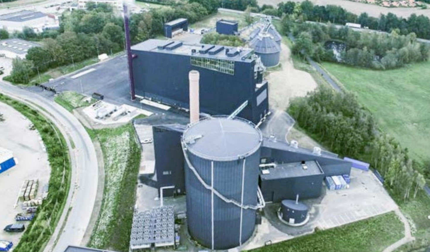
В объем поставки компании ANDRITZ входили котельная установка, от топливных бункеров до выходного отверстия из котла на основе конструкции Ecofluid BFB.
