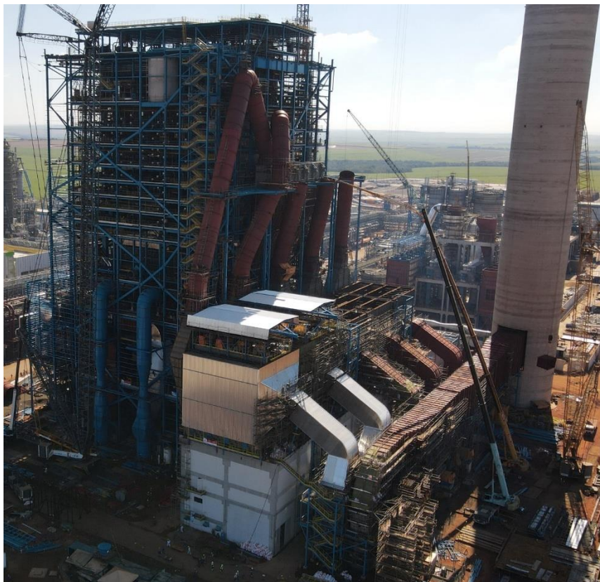
ANDRITZ-Rückgewinnungskessel und 5-Kammer-ESP in der Montagephase
