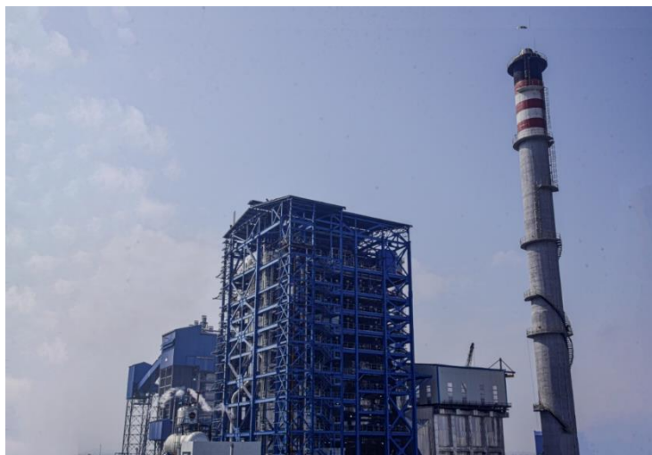
Neuer ANDRITZ HERB-Rückgewinnungskessel bei JK Paper Limited, Gruppe: CP
