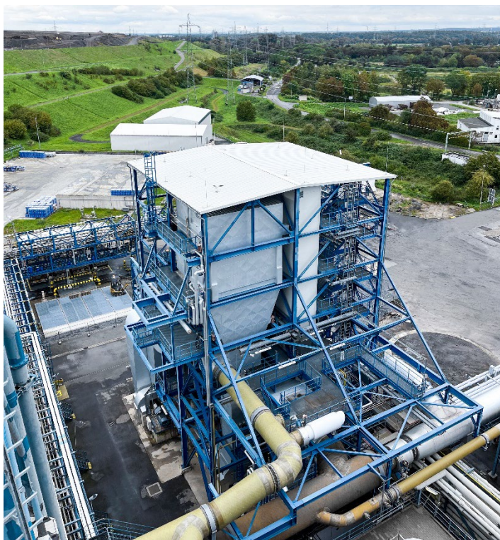
Umbau der SCR II-Einheit
