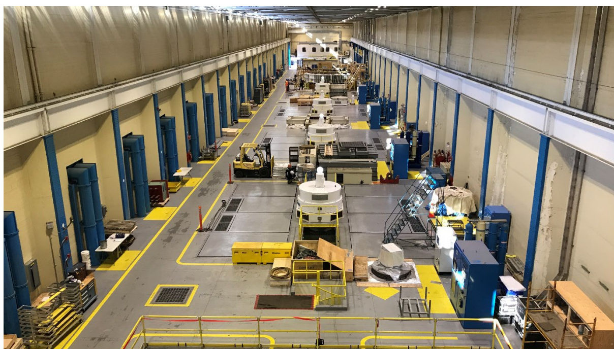
Maschinenhalle des Wasserkraftwerks McCormick in Québec, Kanada Copyright: Société en Commandite Hydroélectrique Manicouagan (SCHM)
