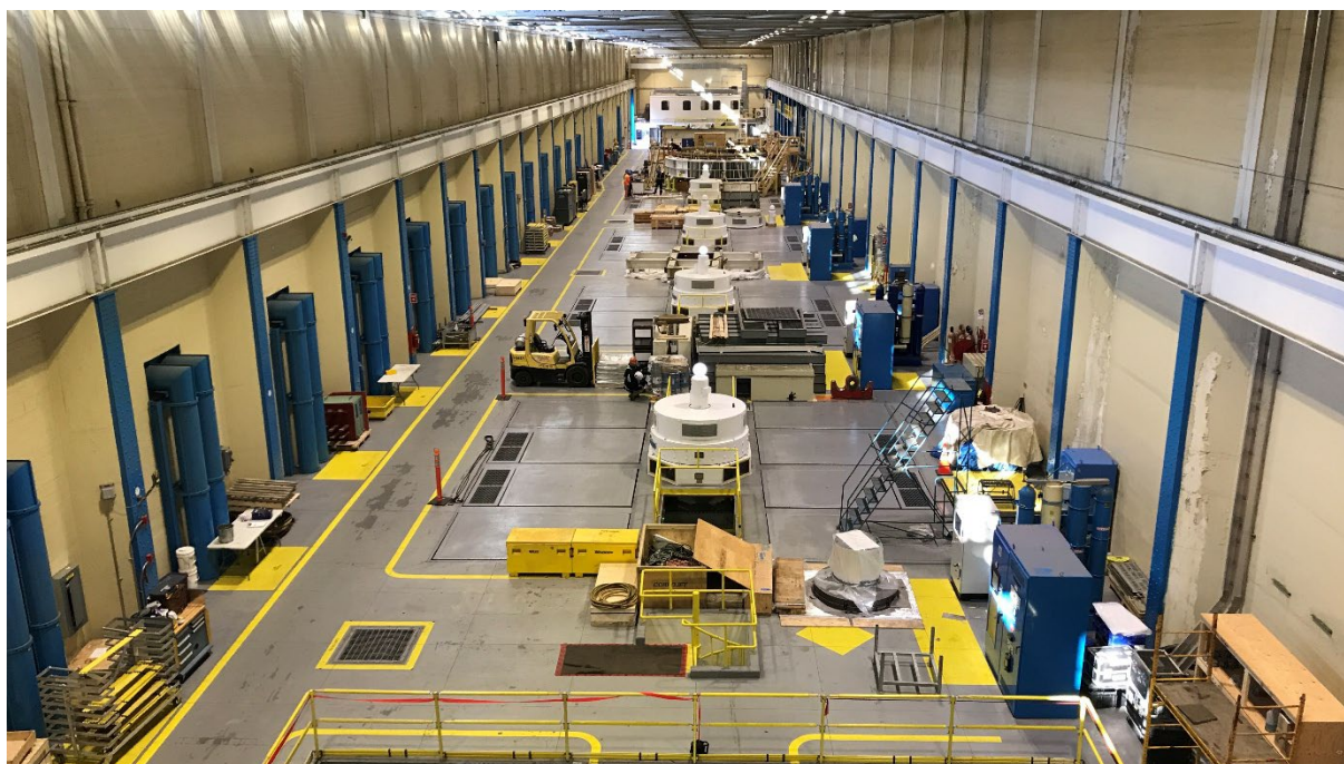
Unit hall of McCormick hydropower plant in Québec, Canada Copyright: Société en Commandite Hydroélectrique Manicouagan (SCHM)
