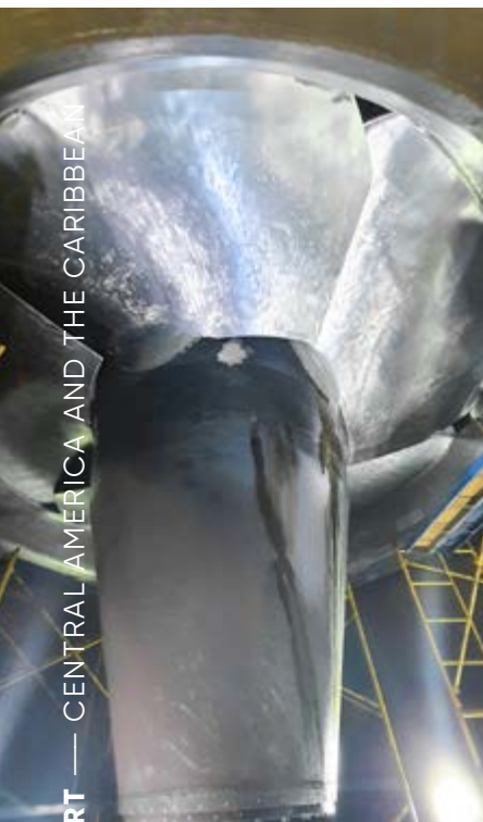
Installation of turbine runner at the 15 de Septiembre hydropower plant, El Salvador
